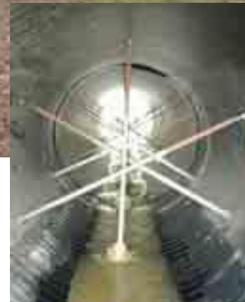
Supports temporaires utilisés pour l'injection de coulis
